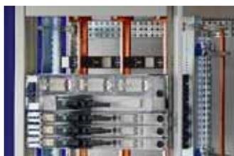
Componentes de sistema para campos para regletas bajo carga para fusibles NH
